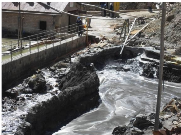
Descarga de colas, Empresa Minera Huanuni
